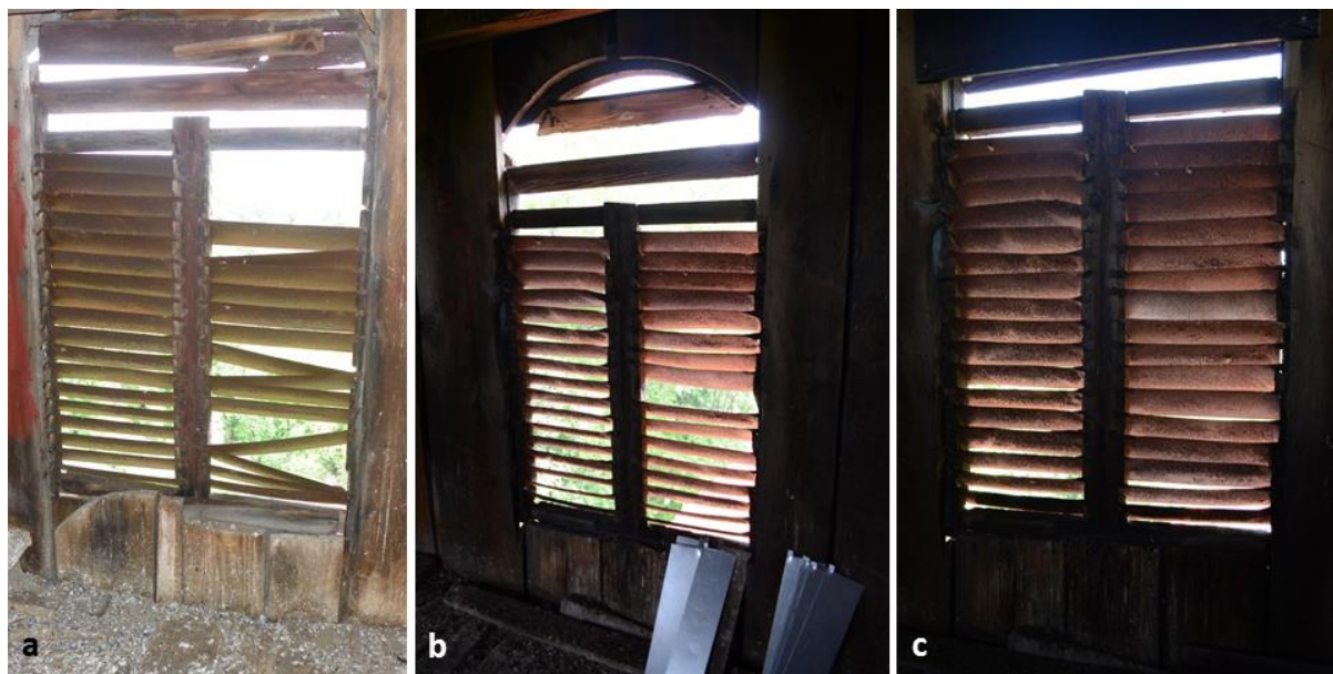
Slika 6: a) Manjkajoče in poškodovane prečne deščice na polkrožnem delu polken in b) v zgornjem polkrožnem delu polken smo c) nadomestili z novimi. S tem smo onemogočili prehod golobom, odprtine pa so še vedno dovolj velike za prehod navadnih netopirjev (Foto: a) Jasmina Kotnik, b in c) Nika Krivec).
