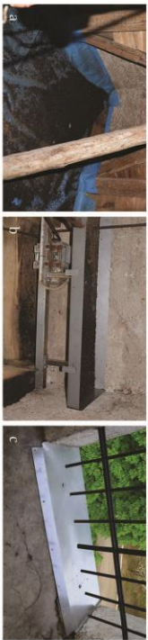
Slika 8. a) Izvedeni ukrepi so zadržali večino gvana v predelu nad zvonovi, b) tudi polica nad mehanizmom za zvonjenje tudi ustrezno zaščitno, c) zamenjane odpadke police (foto: Simon Zidar).
