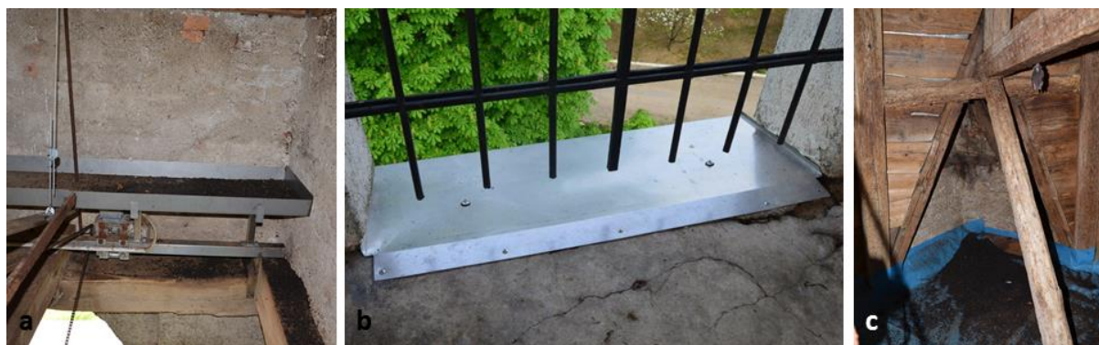
Slika 8: Na cerkvi v Goriči vasi smo izvedli naslednje ohranitvene ukrepe: a) namestili smo zaščitno pločevinasto polico nad mehanizmom za zvonjenje, b) zamenjali odkapne police in c) namestili lesen podest in na njega položili ponjavo (Foto: Simon Zidar).
