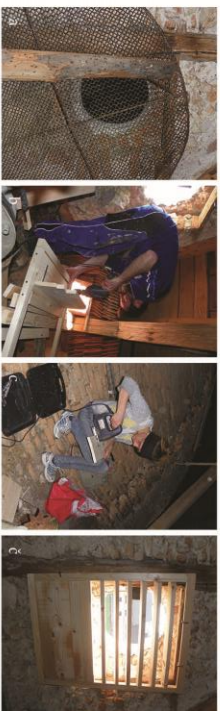
Slika 11. a) Na zastro okroglo odprtino podstrešja smo namestili b) - c) posebno izdelan okvir z vodoravnimi letvicami, ki preprečuje dostop golobom, a omogoča varen prehod navadnim netopirjem (foto: Jasmina Kominik).
