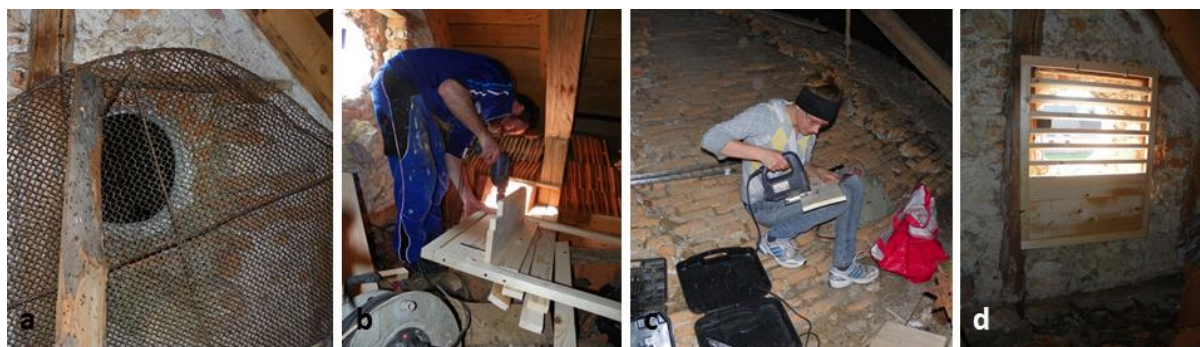
Slika 1: a) Nepravilno zaprta preletna odprtina na cerkvi Sv. Duh v Čenjevku. b in c) Izdelovanje lesenega okvirja. d) Nameščen primeren lesen okvir s prečnimi letvicami v medsebojni razdalji 5 cm (Foto: Jasmina Kotnik).
