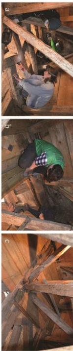
Slika 7. Po temeljnem očiščenju zvonika (a) smo se lotili izdelave lesenega podesta (b in c), ki bo preprečeval padanje gvana na zvonove (foto: Simon Zidar).
